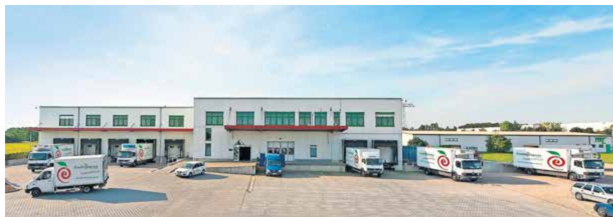
Die Zentrale von Fruchtextpress in Altenburg. FOTO: PR
