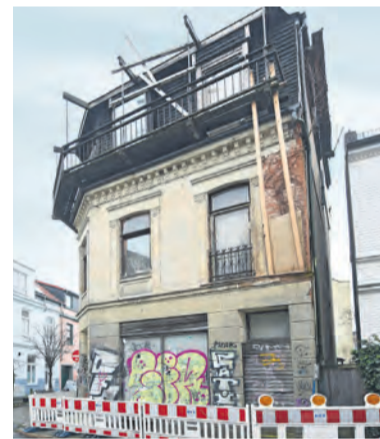
An der Alexanderstraße wurde bereits eine Absperrung errichtet, um Fußgänger zu schützen.
